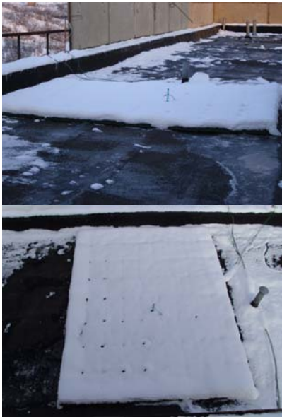
Imagini ale acoperișului terasă fără zăpadă și ale acoperișului verde modular cu zăpadă (25.01.2011)
